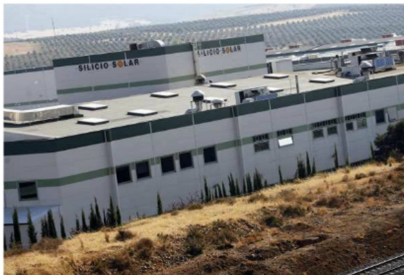
INSTALACIONES DE SILICIO SOLAR, AHORA PROPIEDAD DE AURINKA. / PABLO LORENTE
